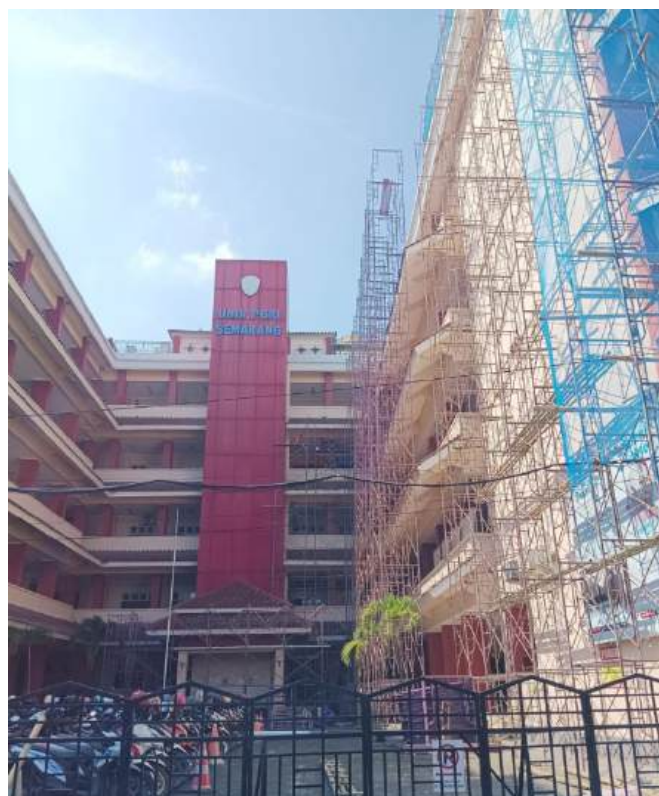
Keadaan Gedung Utama ketika direnovasi
