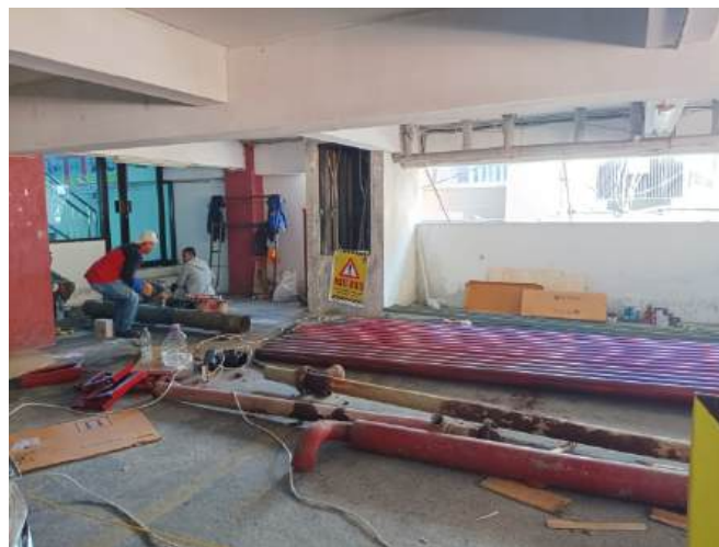
Pemasangan Hidran di Gedung Pusat
